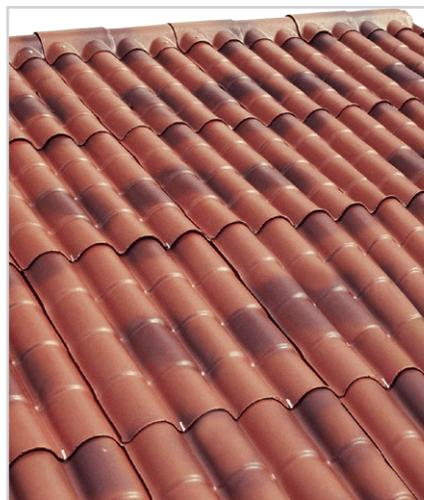
Las tejas españolas tienen un solo sentido de montaje (de izquierda a derecha). Su montaje debe iniciarse de abajo hacia arriba, en el orden indicado.
