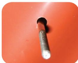
**Nota:** Siempre realice la perforación de las tejas en la cresta y no en el valle, utilice broca con un diámetro mayor al del elemento de fijación 3/16" (4.8mm), nunca perforo con puntilla. NO UTILICE MARTILLO.
