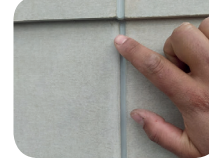
Vista general de la junta flexible terminada
