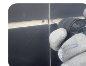
Instalación tornillo de fijación.
