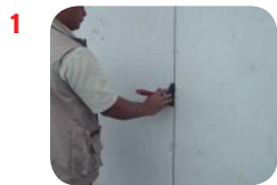
1 Limpieza de la junta con brocha
