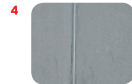
4 Vista general de la junta flexible terminada
