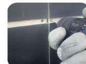
Instalación tornillo de fijación.
