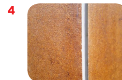
Vista general de la junta flexible terminada
