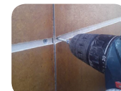
Instalación tornillo de fijación.
