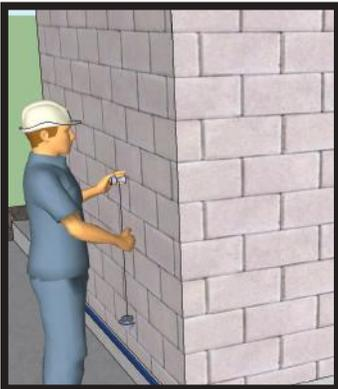
Antes de instalar sobre una pared de concreto la Fachada Tek, es necesario asegurarse que se encuentre la superficie aplomada y uniforme, para evitar deformaciones en el producto y alteración del acabado.
