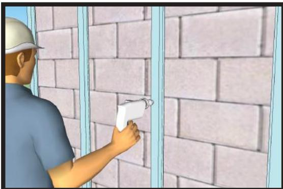
Recomendamos en zonas de alta humedad considerar el uso de una barrera de humedad, en caso de que la pared de concreto no esté repellada o impermeabilizada.
