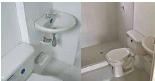
Enchape zona húmeda e instalación de sanitario, lavamanos y apliques.
