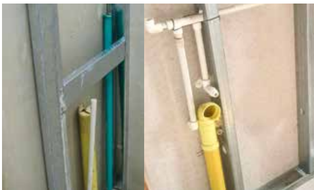
Sanitario y lavamanos. Estructura Drywall para conformar el muro de servicios.
