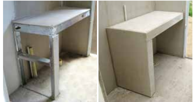
Estructura en acero galvanizado y armado del mesón con Placas Eterboard.
