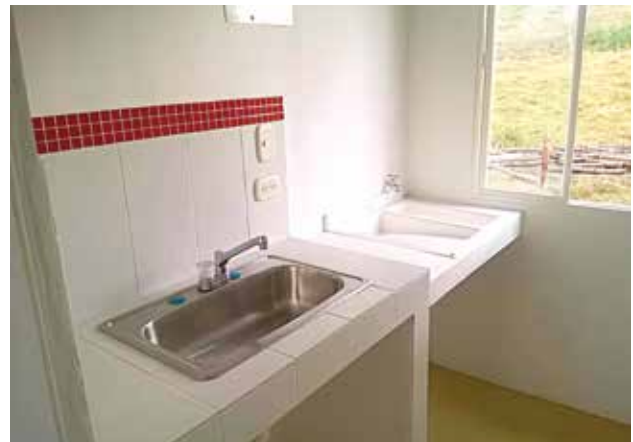
Instalación del enchape, lavaplatos y lavadero.
