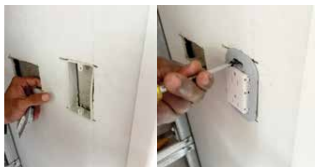
Soporte base interruptor. Instalación accesorio toma.
