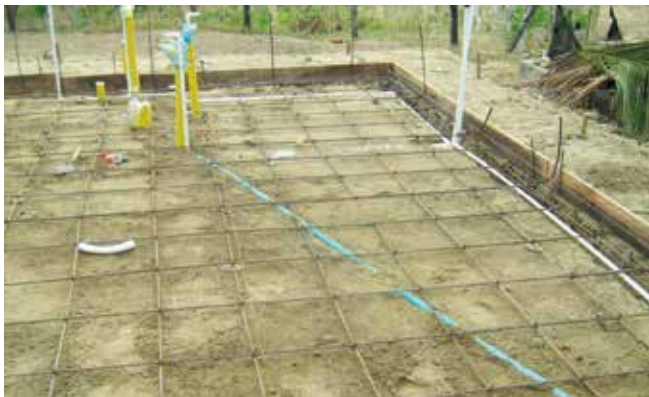
Tendido de redes y armado de parrilla.
