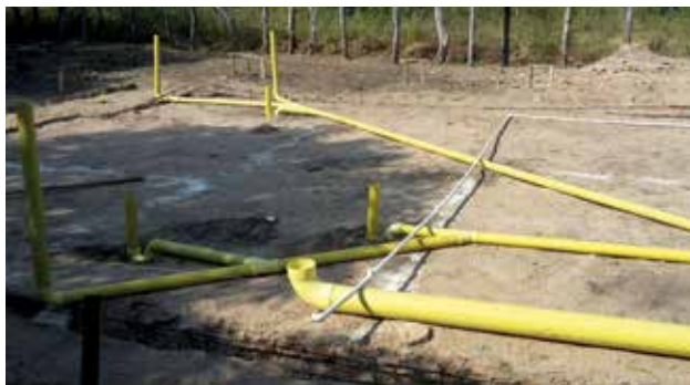
Tendido de las tuberías previo a la fundición de la losa.
