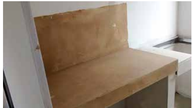
La zona a enchapar se debe aplicar un recubrimiento con Masilla Etercoat con el fin de proporcionarle adherencia a la Placa Eterboard.
