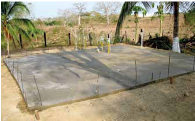
Losa o plantilla terminada y fraguada.
